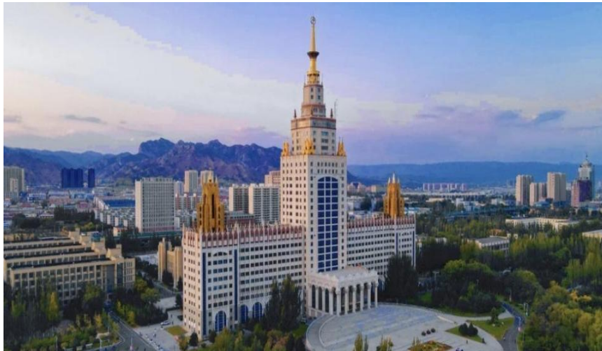
内蒙古工业大学金川校区电力大楼
